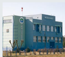
Miejskie Wodociągi i Oczyszczalnia, Grudziądz, Polska
