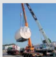
Ładowanie w wytwórni żurawiami samochodowymi
