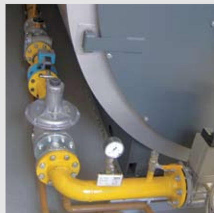
Rys. 23: Zestaw przedpalnikowej armatury gazowej
