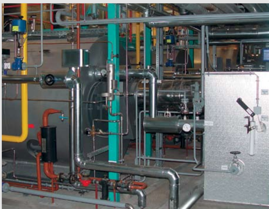
Rys. 43: Kocioł parowy Vitomax 200-HS z dostawionym ekonomizerem (z prawej)
