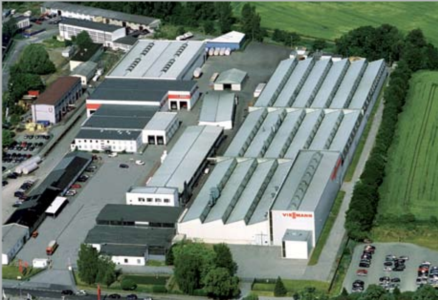
Wytwórnia kotłów dużej mocy w zakładzie Mittenwalde
