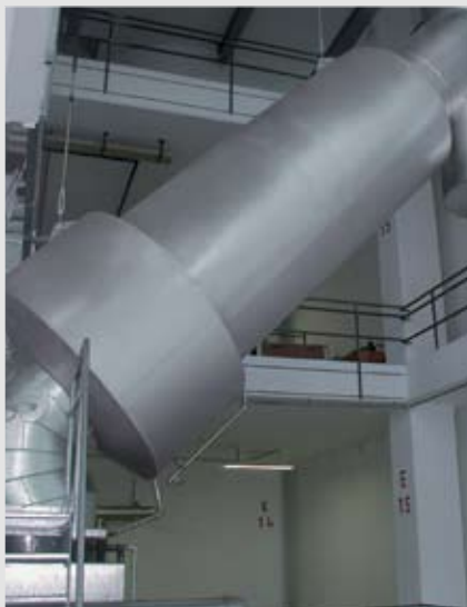
Rys. 44: Tłumik hałasu przepływu spalin
