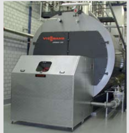
Rys. 76: Osłona dźwiękochłonna palnika
