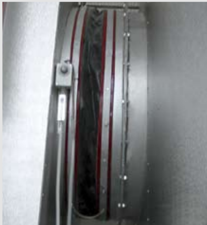
Rys. 75: Kompensator przewodu spalin
