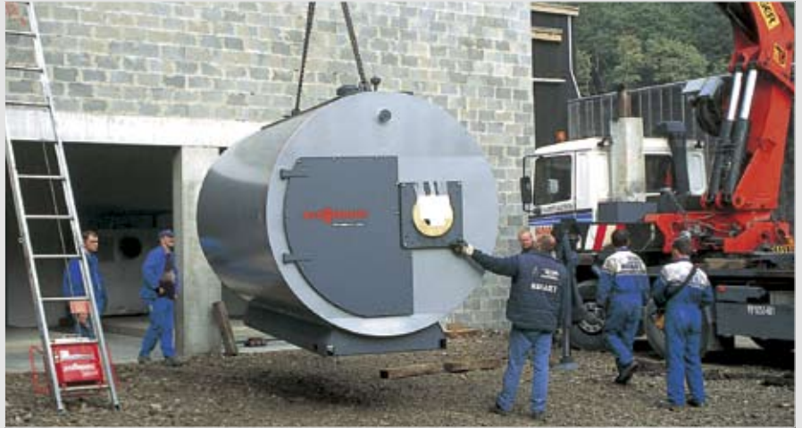
Rys. 80: Wstawianie kotła dużej mocy wymaga doświadczenia i wyczucia
