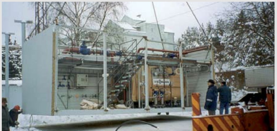
Rys. 84: Wstawianie kotła Vitomax 200-HS (typ M237) w Estonii
