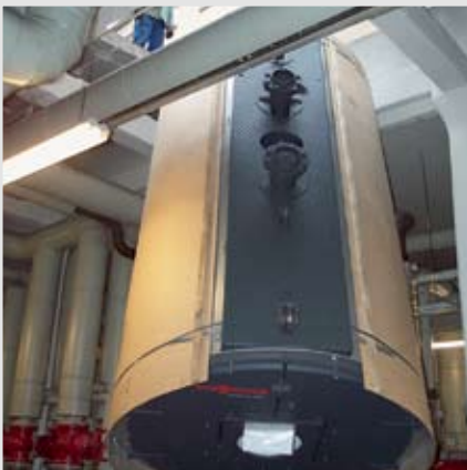
Rys. 83: Wstawianie kotła przez dach
