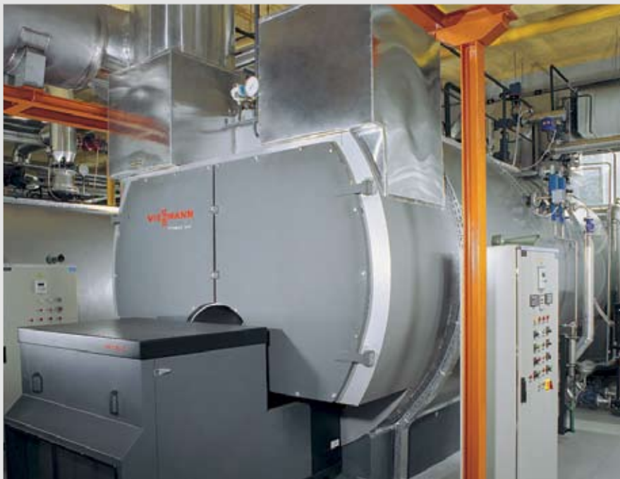
Rys. 91: Kocioł parowy Vitomax 200-HS z wykorzystaniem ciepła odpadowego w szpitalu w Maribor, Słowenia (6 t/h, 13 bar, para nasycona)
