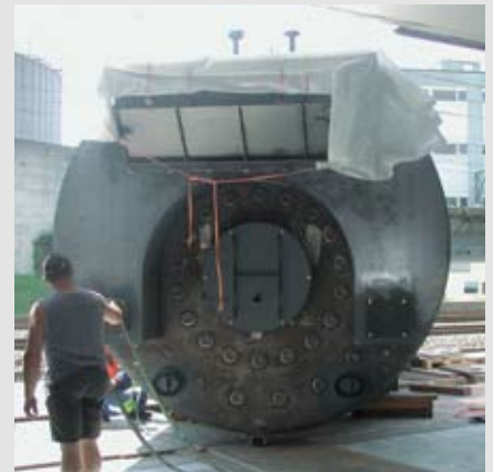
Rys. 82: Wstawianie kotła bez izolacji cieplnej
