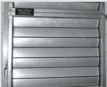
Rys. 77: Otwór nawiewu powietrza z tłumikiem dźwięku
