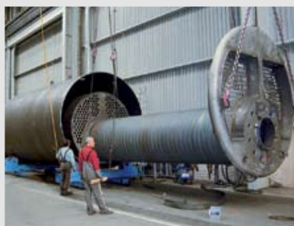
Montaż płaszcza kotła z płomienicą
