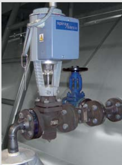
Rys. 32: Zawór odsalający
