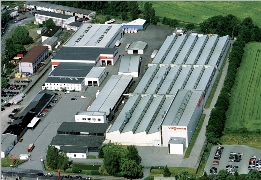
Wytwórnia kotłów dużej mocy w zakładzie Mittenwalde
