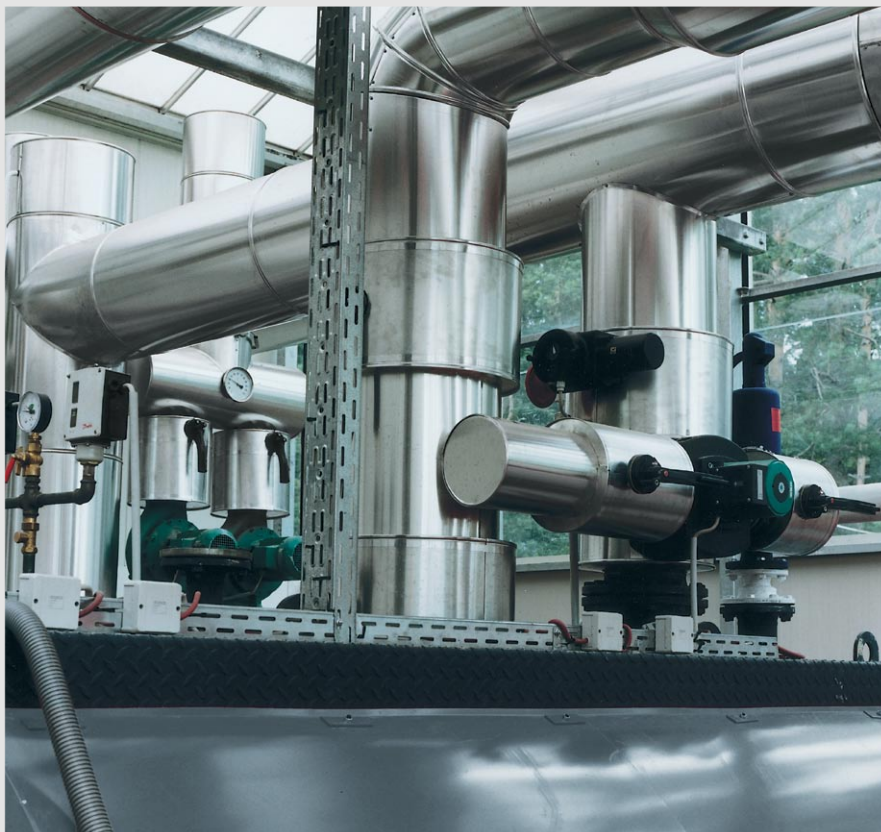
Rys. 55: Układ podnoszenia temperatury w kotłach grzewczych Vitomax
