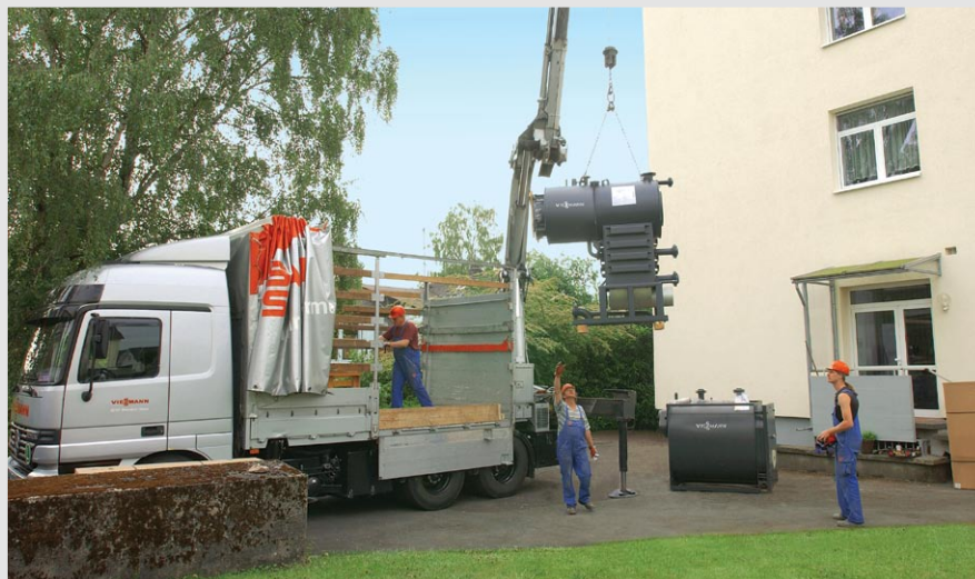
Rys. 65: Dostawa i wstawianie kotła samochodem firmowym z żurawiem
