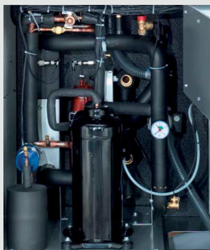
Rys. 56: Komponenty pompy ciepła powietrze/woda
