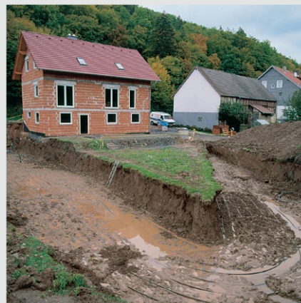
Rys. 24: Kolektor gruntowy
