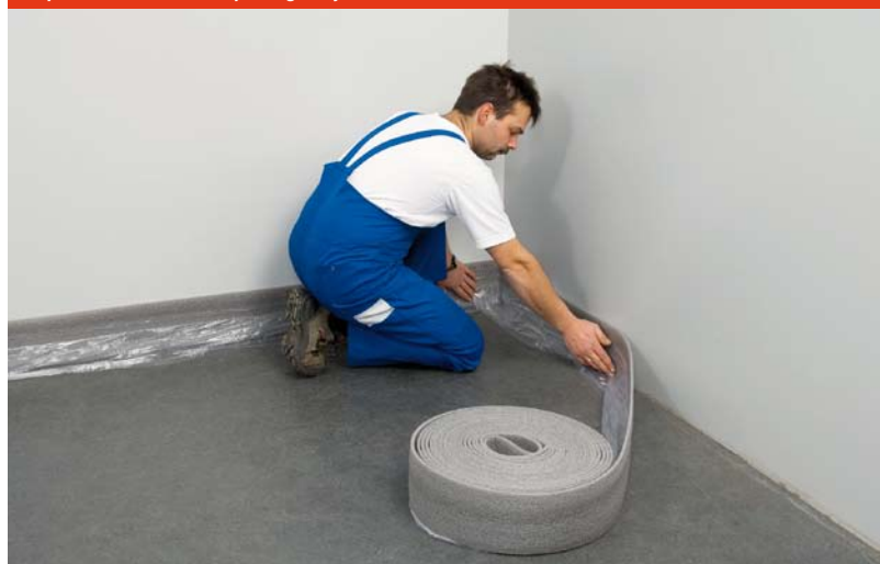
Rys.2. Układanie taśmy brzegowej
