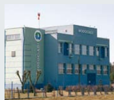
Miejskie Wodociągi i Oczyszczalnia, Grudziądz, Polska
