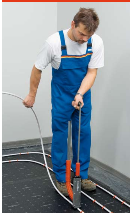
Rys.4. Układanie rury grzewczej
