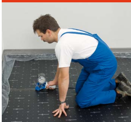
Rys.3. Oklejanie taśmą samoprzylepną krawędzi styku płyt izolacyjnych
