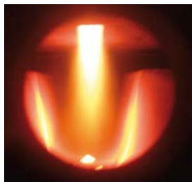
Technika zgazowywania w kotle Vitoligno 100-S
