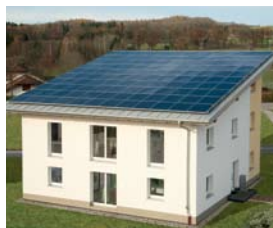
Bateria słoneczna z modułów fotowoltaicznych Vitovolt
