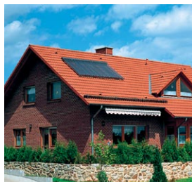
Vitosol 300-T zamontowany na dachu domu
