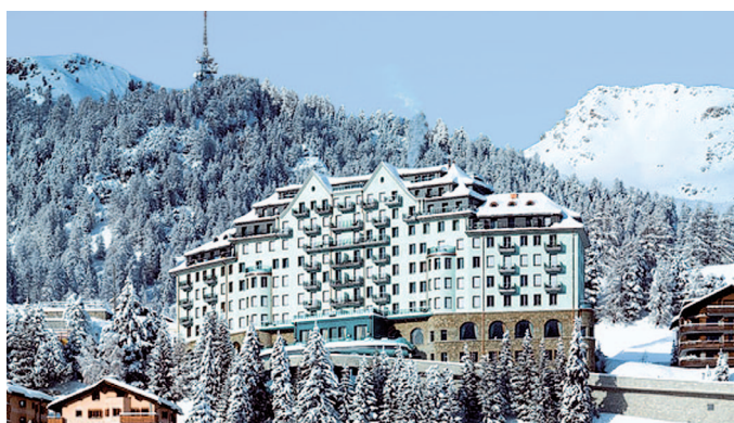
W pięciogwiazdkowym hotelu Ritz Carlton w St. Moritz ścieki wykorzystywane są do pozyskania ciepła do ponownego podgrzewu wody.
