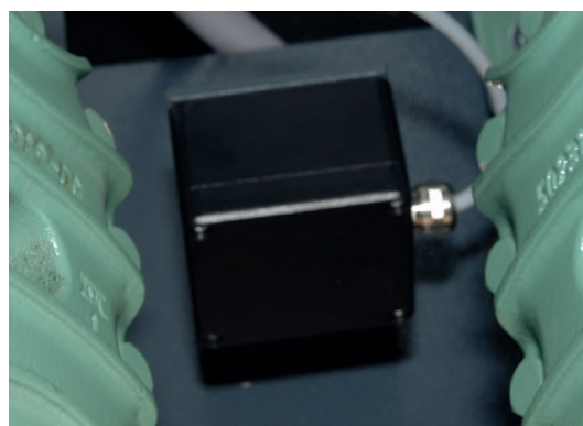
Automatyczny nadzór szczelności za pomocą wykrywacza gazu
