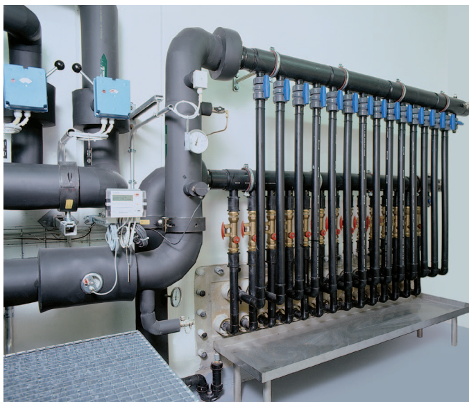
Rozdzielacz sond gruntowych
