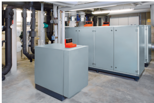
Pompy ciepła Vitocal 300-G PRO (po prawej) i Vitocal 300-G (po lewej)
